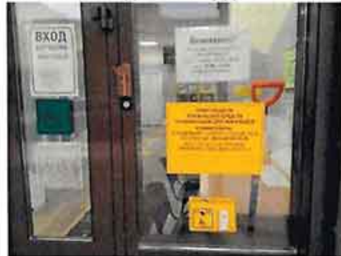
Фото № 4. Входная площадка
